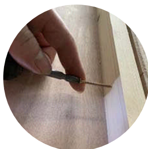
Upevnění stropu
