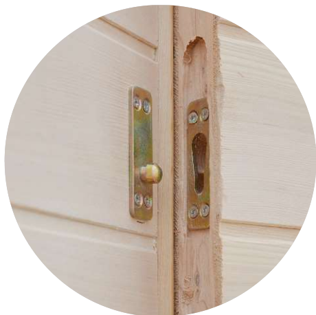
System spojění stěn
