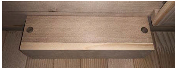
Zakrytý spoj káblov
