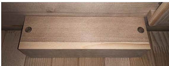
Zakrytý spoj kabelů
