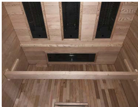
Instalovaná podpora lavice
